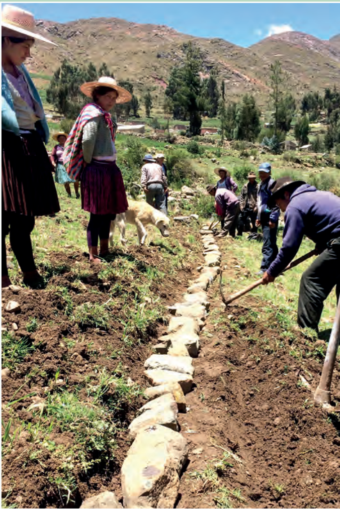
Foto: Zanjas de infiltración.
